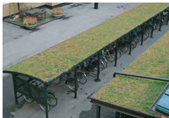
Cykelparkering med sedumtak
