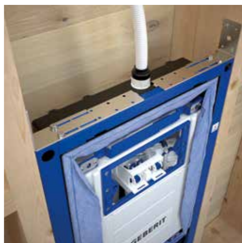
Inbyggadcisternen ansluts uppifrån med rör-i-rör. Röret fästs säkert och tätt mot säkerhetsboxen.
